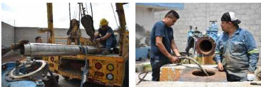
Como parte de la programación presupuestaria de la comisión del agua y saneamiento del municipio de Tlahuelilpan, se realizó la adquisición de 2 medidores y el servicio de instalación en los Pozos Cerro de la Cruz y Miravalle para conocer el volumen de extracción de agua potable.
